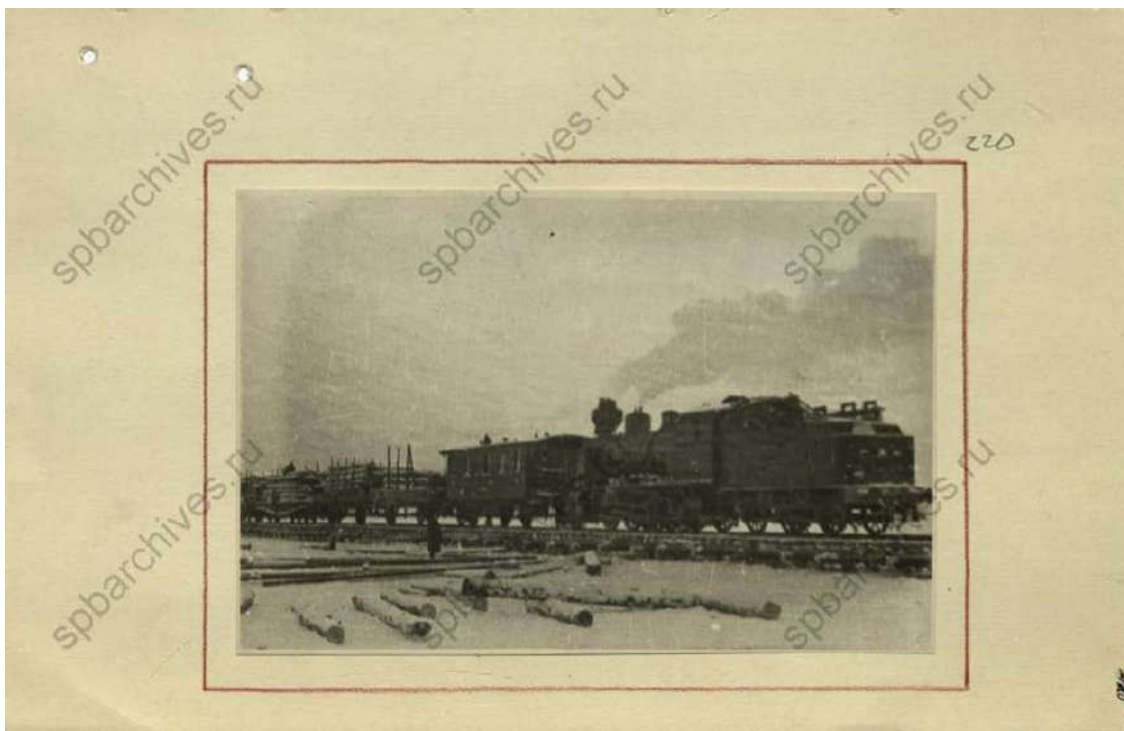
Рис. 3. Обкатка свайно-ледовой железной дороги на Ладожском озере в 1942 г.
