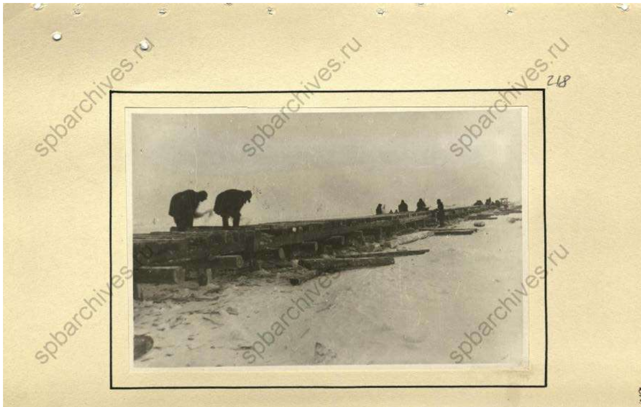
Рис. 2. Строительство свайно-ледовой железной дороги через лед через Ладожское озеро зимой 1942/1943 г.
