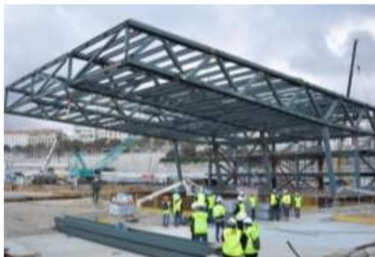
Рис. 2. Каркас здания «Дом Средиземноморья»
